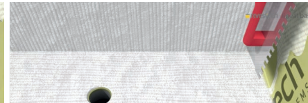
14. Нанесіть плитковий клей на мембрану
